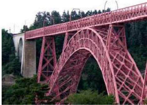
Viaduc de Garabit
