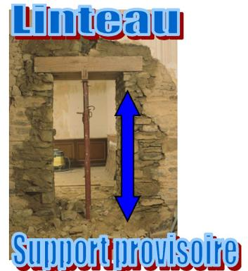
Il est nécessaire de maintenir le linteau sur les murs sur une distance de minimum 25 cm pour assurer une bonne transmission des efforts sur le mur. La distance d'ouverture s'appelle la portée.
