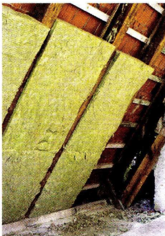
Laine de verre en toiture.
